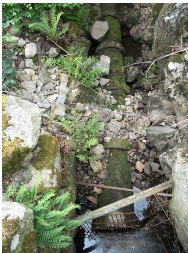
Figur 10. Øverste vandringshinder, rør som ligger i dagen
